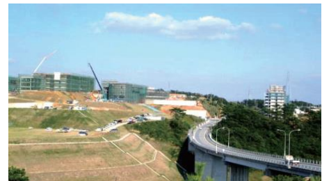
2003(平成15)年 10月 コスト面、自然との調和を考慮して採用された法面工法 法面の崩壊を防ぐために水平方向にアンカーボルトを一定間隔で打ち込んである
