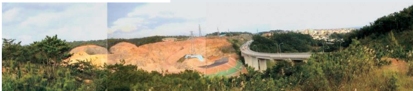
2003 (平成15) 年 1月 運動場側は、校舎側(切土)からの土を盛土を行った
