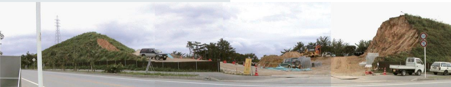
2002 (平成14) 年 11月 寄宿舍 (学生寮側)
