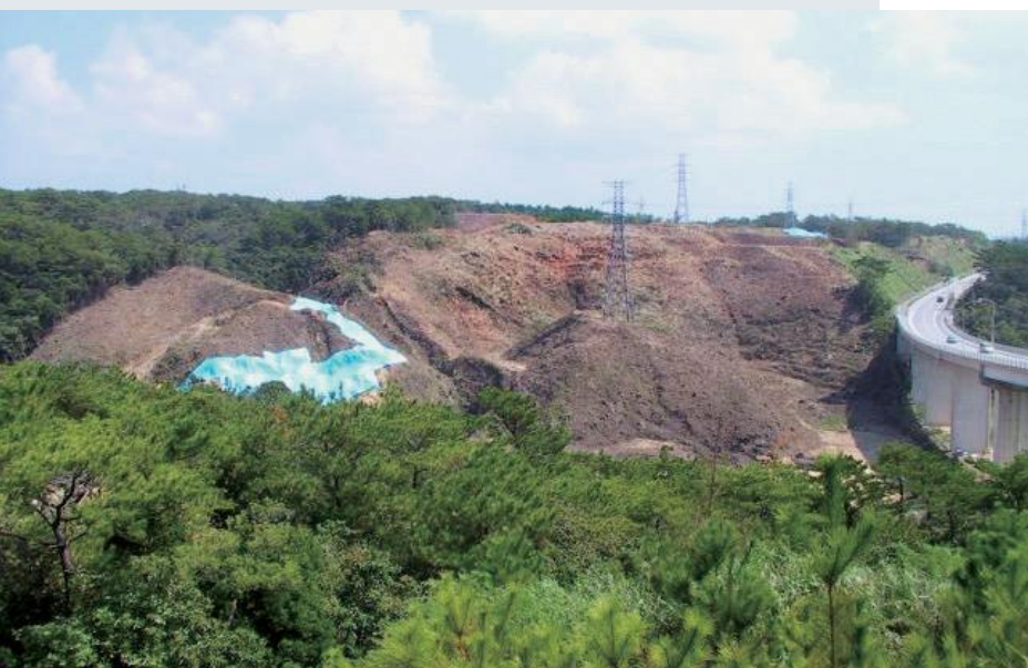
2002 (平成14) 年 12月 沈砂地を築造し、赤土流出防止対策を実施して 周辺環境に配慮を行った
