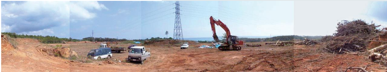
2002（平成14）年 2月 メディア棟工事現場
