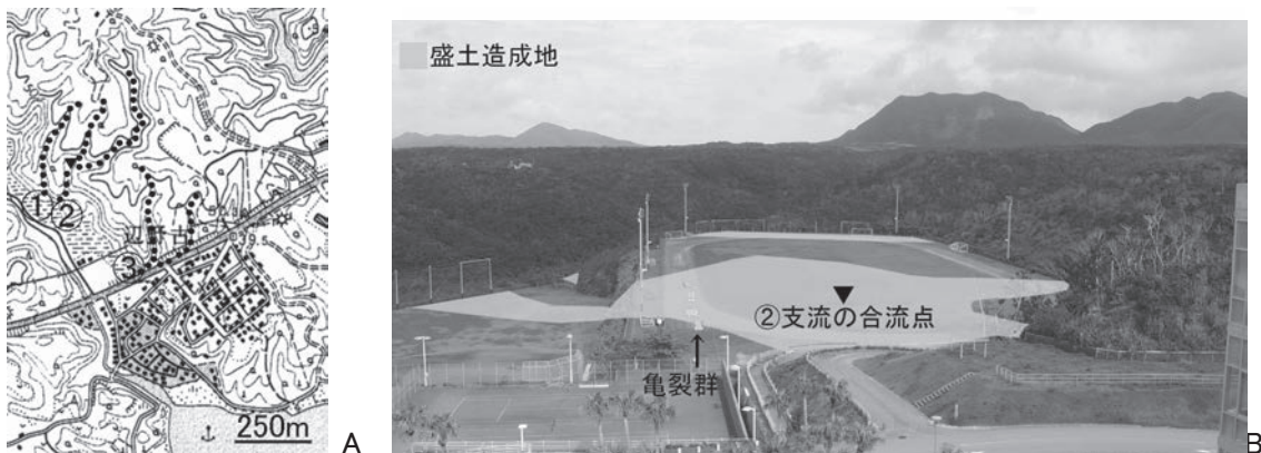
図4 沖縄高専周辺の原地形(A)と創造実践棟から見た造成地の景観(B:陸上競技場のバックストレートを覆うブルーシートが2012年梅雨季に生じた亀裂)
