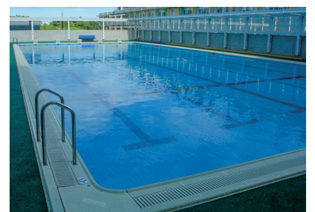
⑧ 屋外プール
