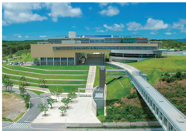
国道329号側から眺める建物外観
