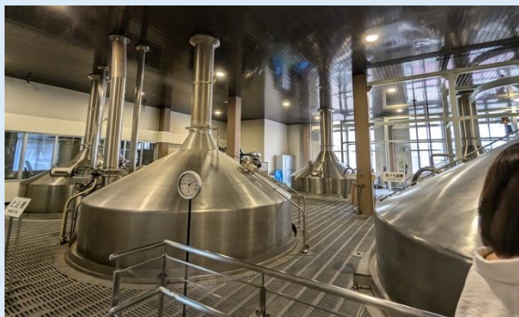
↑東江工場にて見学させていただいた施設
